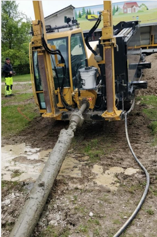
Grabenlose Verlegung im günstigen Spülbohrverfahren
