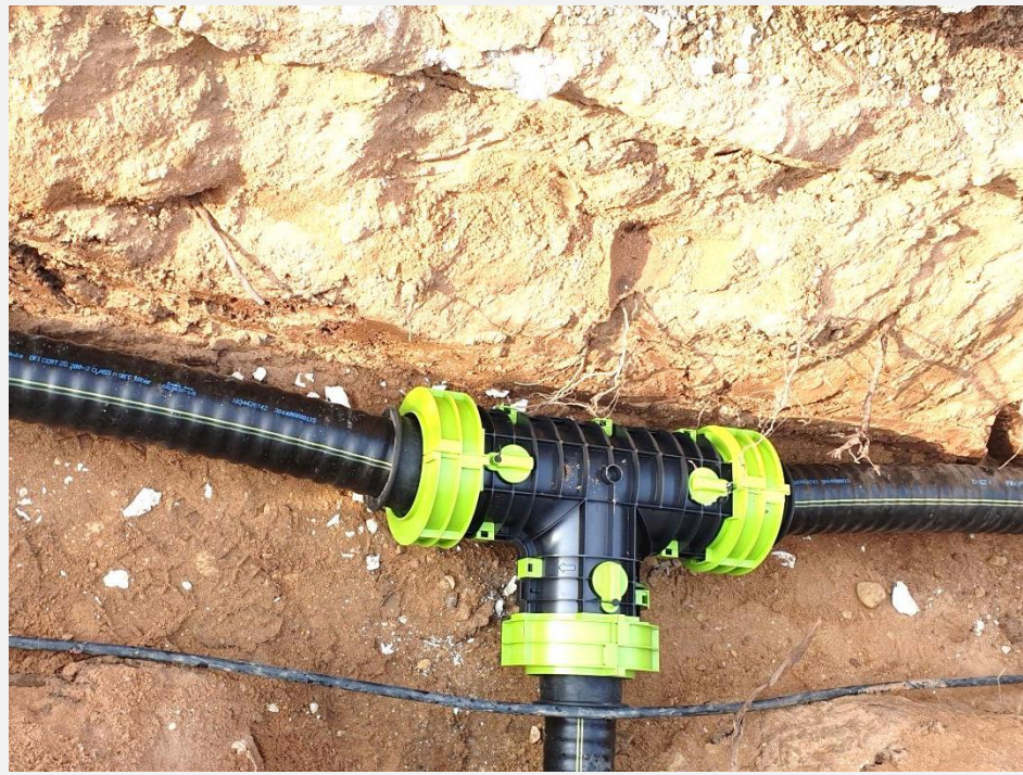
T-Stück im offenen Graben
