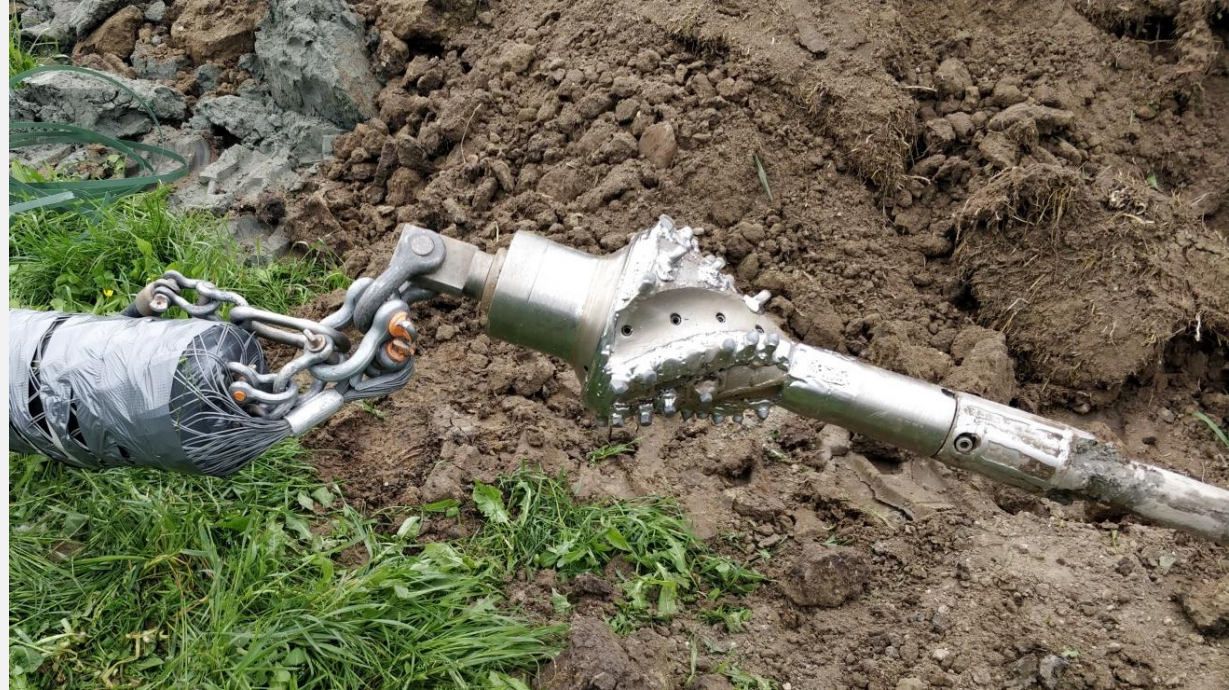
Grabenlose Verlegung im günstigen Spülbohrverfahren
